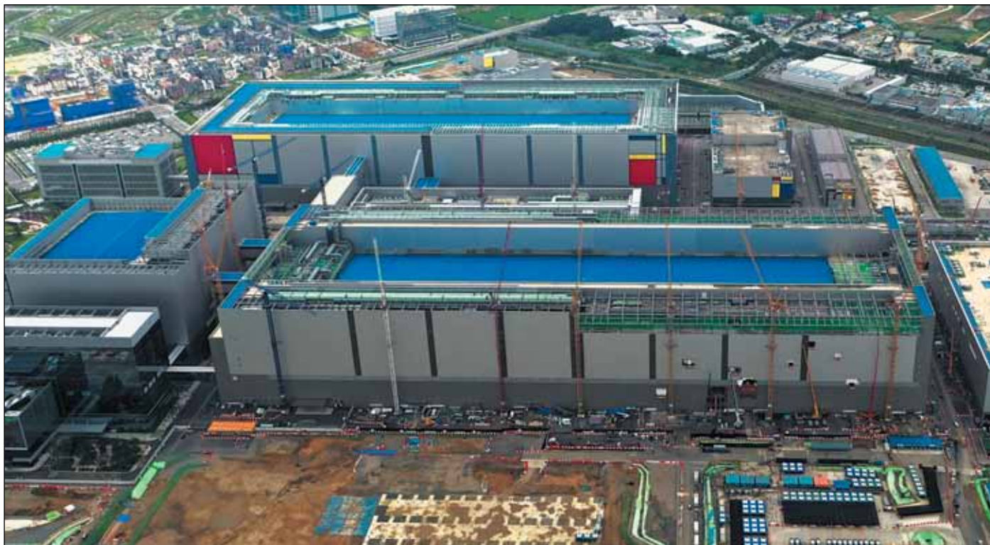
Рис. 1. Строительство завода по производству полупроводников Samsung Electronics в Пхэнтхэе, август 2020 года
